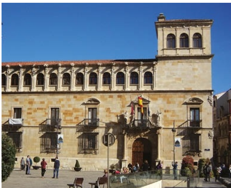
León. Palacio de los Guzmanes, construido por Rodrigo Gil de Hontañón. La portada, guardada por dos reyes de armas, está inusualmente desplazada del centro de la fachada. Reducida la decoración a puertas y ventanas, un tercer piso de arquillos corridos remata el edificio. Foto: Carlos Javier Taranilla.
