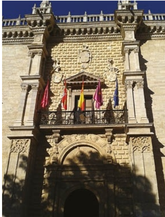
Valladolid. Palacio de Santa Cruz. Pilastras coronadas con pináculos y adosadas al muro, al estilo gótico, enmarcan la portada. Se observa el empleo de sillares en almohadillado, de origen florentino, para adornar la pared. Foto: Carlos Javier Taranilla.
