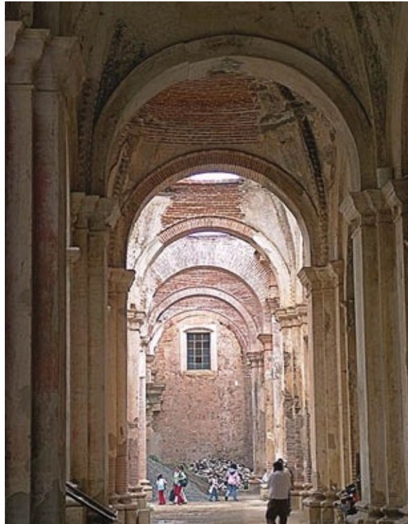
Ruinas del interior de la iglesia del convento de La Antigua, en Guatemala. Los arcos fajones que sujetaban las bóvedas, en algunos tramos, parecen ya solamente sostener el aire.
