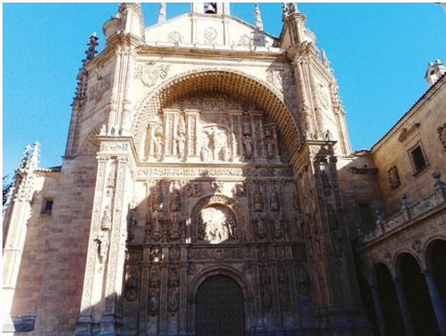
Iglesia de San Esteban en Salamanca, obra de Juan de Álava, prototipo del modelo de fachada retablo, que imita la división estructural en calles y pisos con el clásico Calvario en el ático. Foto: Carlos Javier Taranilla.
